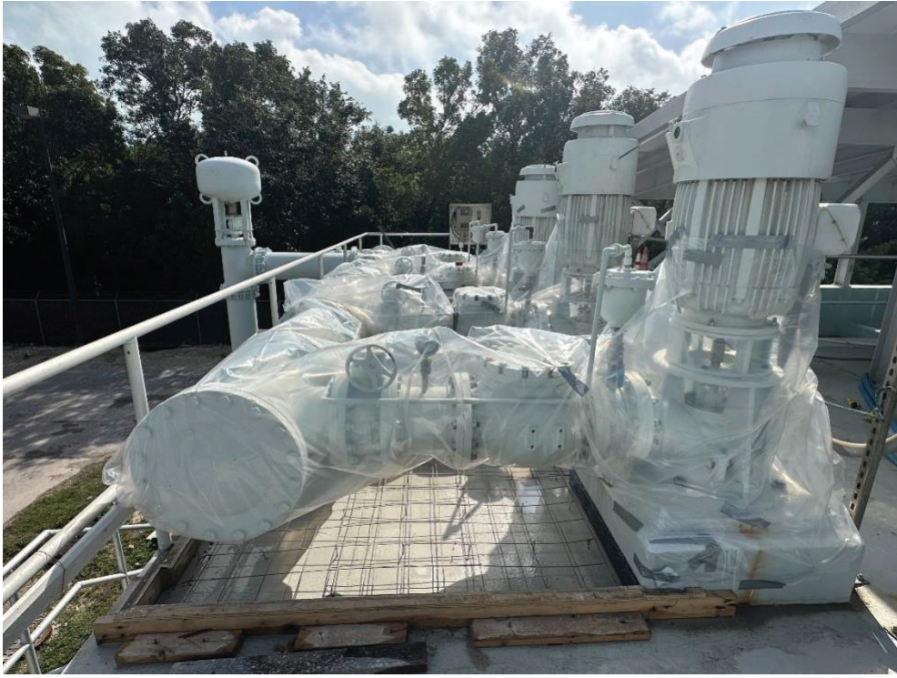
Effluent Filtration Upgrades Project: Effluent pump drain slab ready for concrete pour
